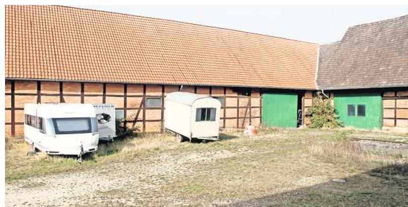
Der linke Gebäudeteil des Stümpelhofs bleibt erhalten.
